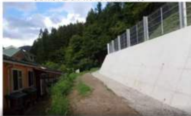
【急傾斜地対策(待ち受け擁壁工)】
